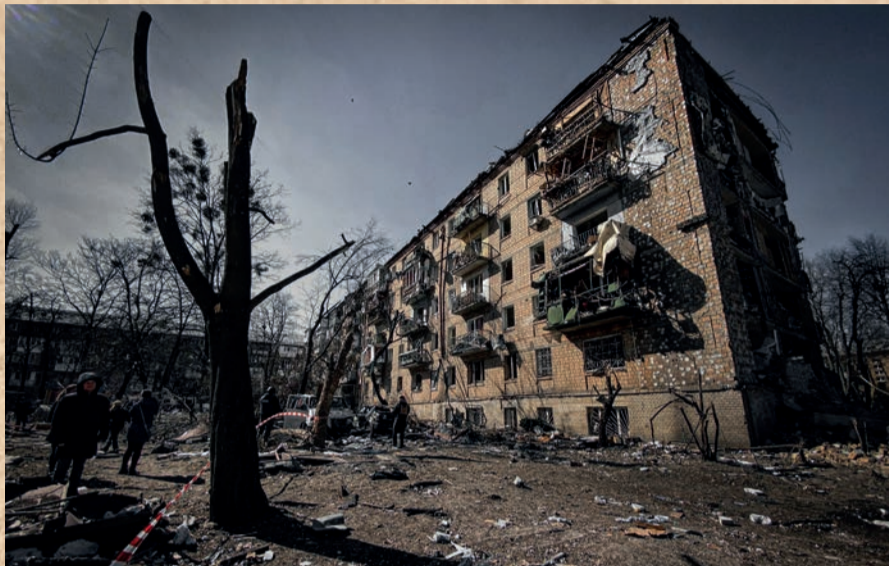
Beschadigde flat in Oekraïne.
